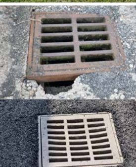
Oprava komunikace - odvodů dešťové vody
