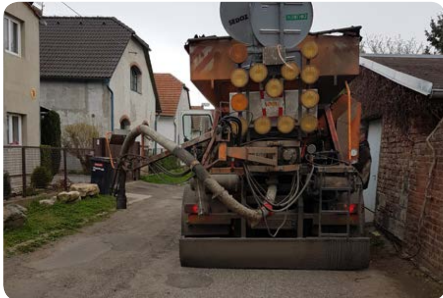
Oprava silnice v ulici Bezručova
