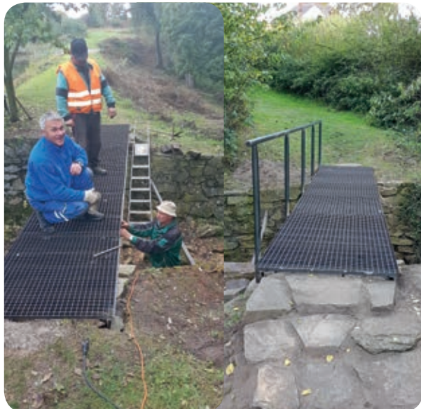
Oprava lávky (R. Dudík, R. Paďouk, Z. Vokoun) a nová lávka v Ratboři
