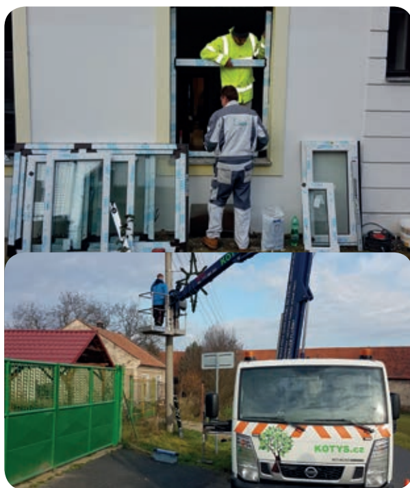
Výměna oken v čp. 88 a instalace Vánočního osvětlení
