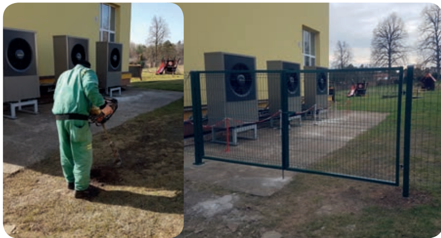
Příprava a hotové nové pločení MŠ
